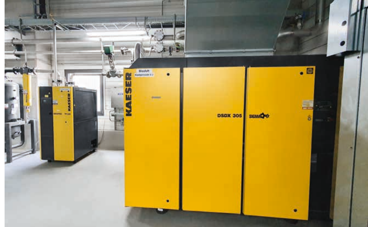
Ο κοχλιοφόρος αεροσυμπιεστής DSDX 305 της KAESER παρέχει τον απαιτούμενο αέρα εμφύσησης για τις προσωρινές αιχμές κατανάλωσης.
